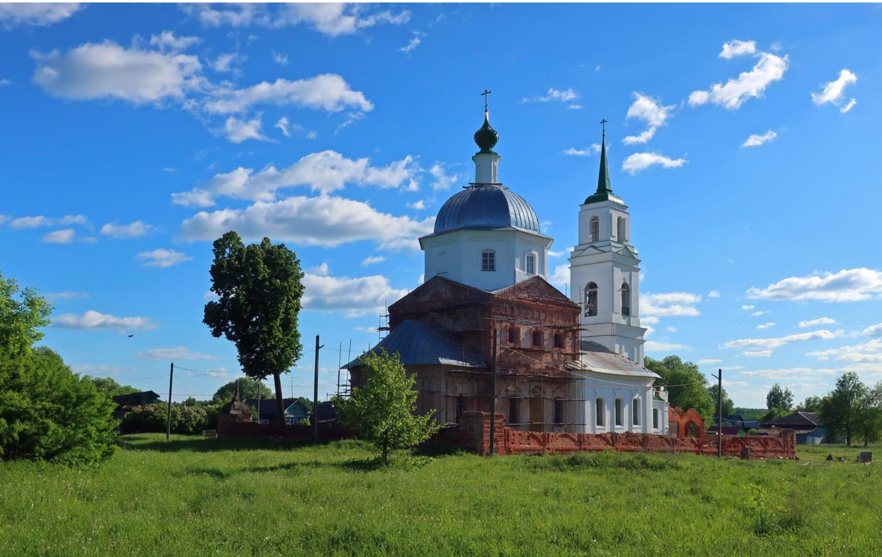
Церковь Сергия Радонежского, с. Мосейцево, Ярославская область
